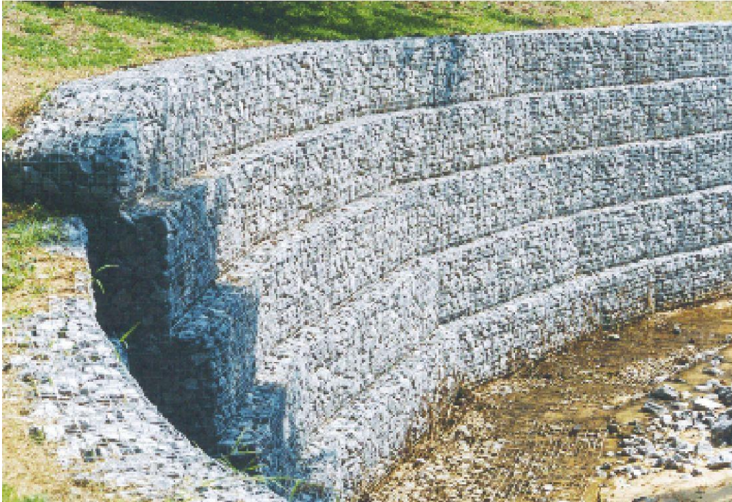
Photo 9 : Exemple de falaise aménagée avec un mur en gabion
