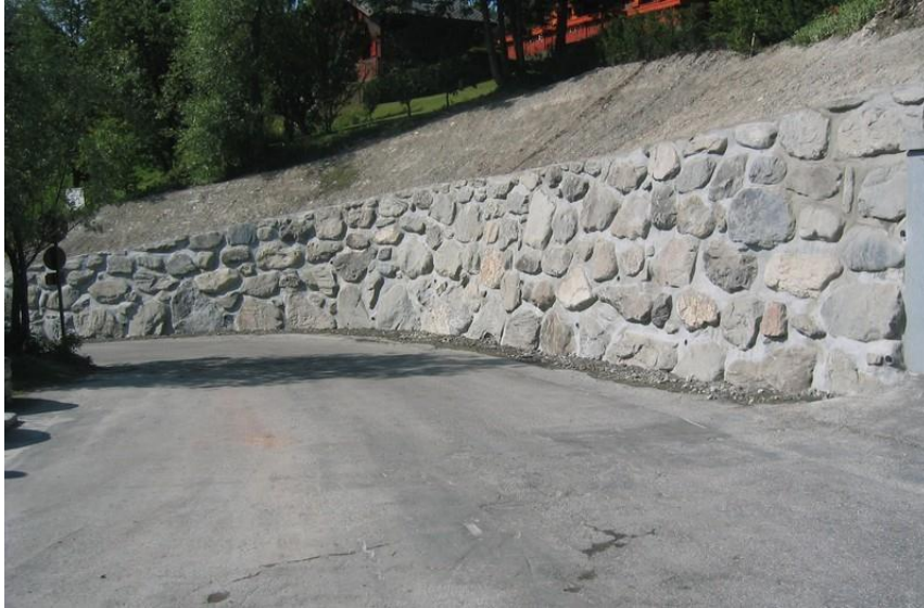
Photo 10 : Exemple de falaise aménagée avec un mur en perré maçonné
